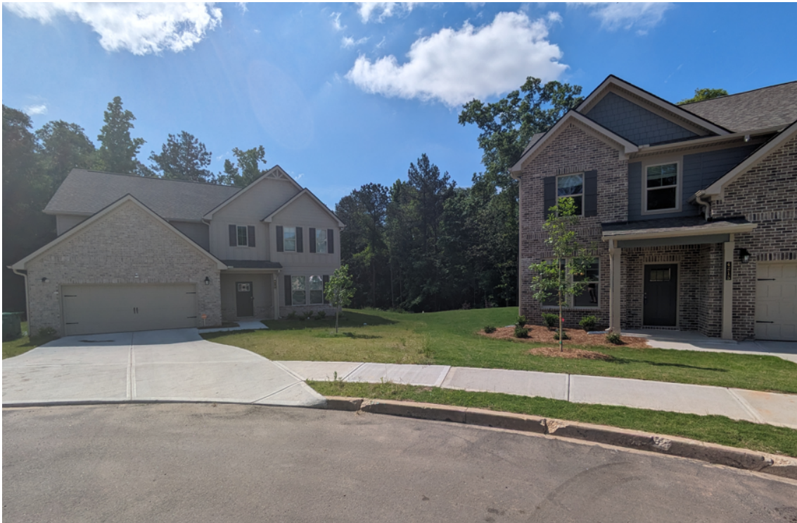
Cedar Grove Commons Lot #17 4215 Cedar Grove Commons Way (Right)
